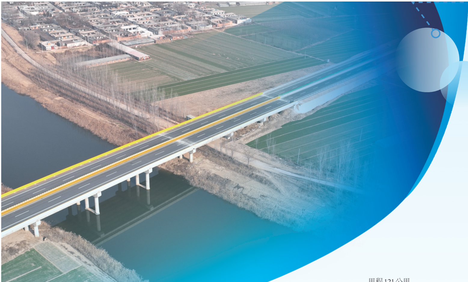
聊城大外环路S246临郛线路使胶河大桥
